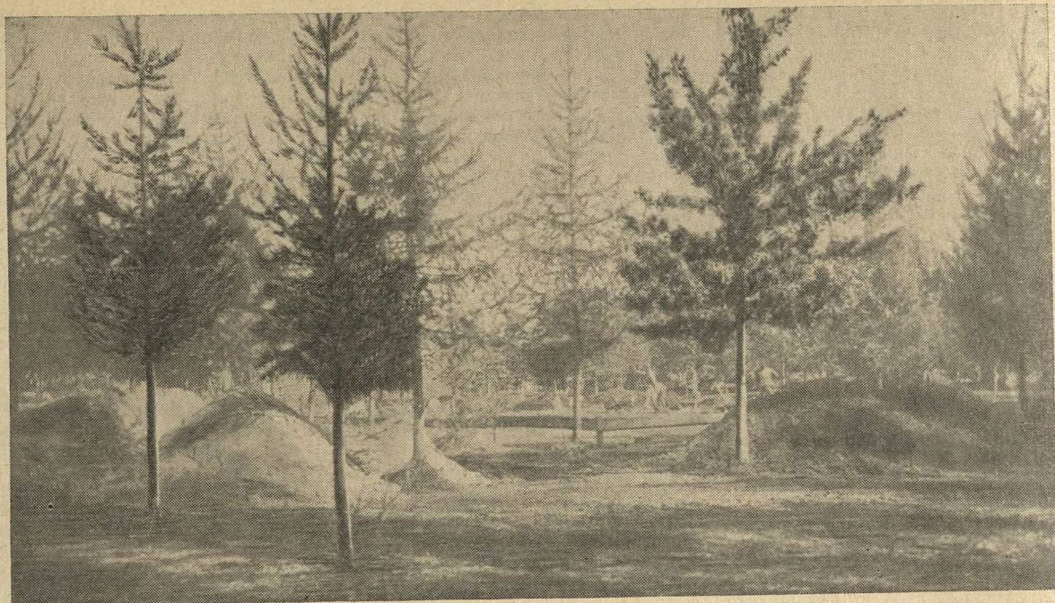
Здесь начиналось строительство мочильного отделения Лихославльского льнозавода.
